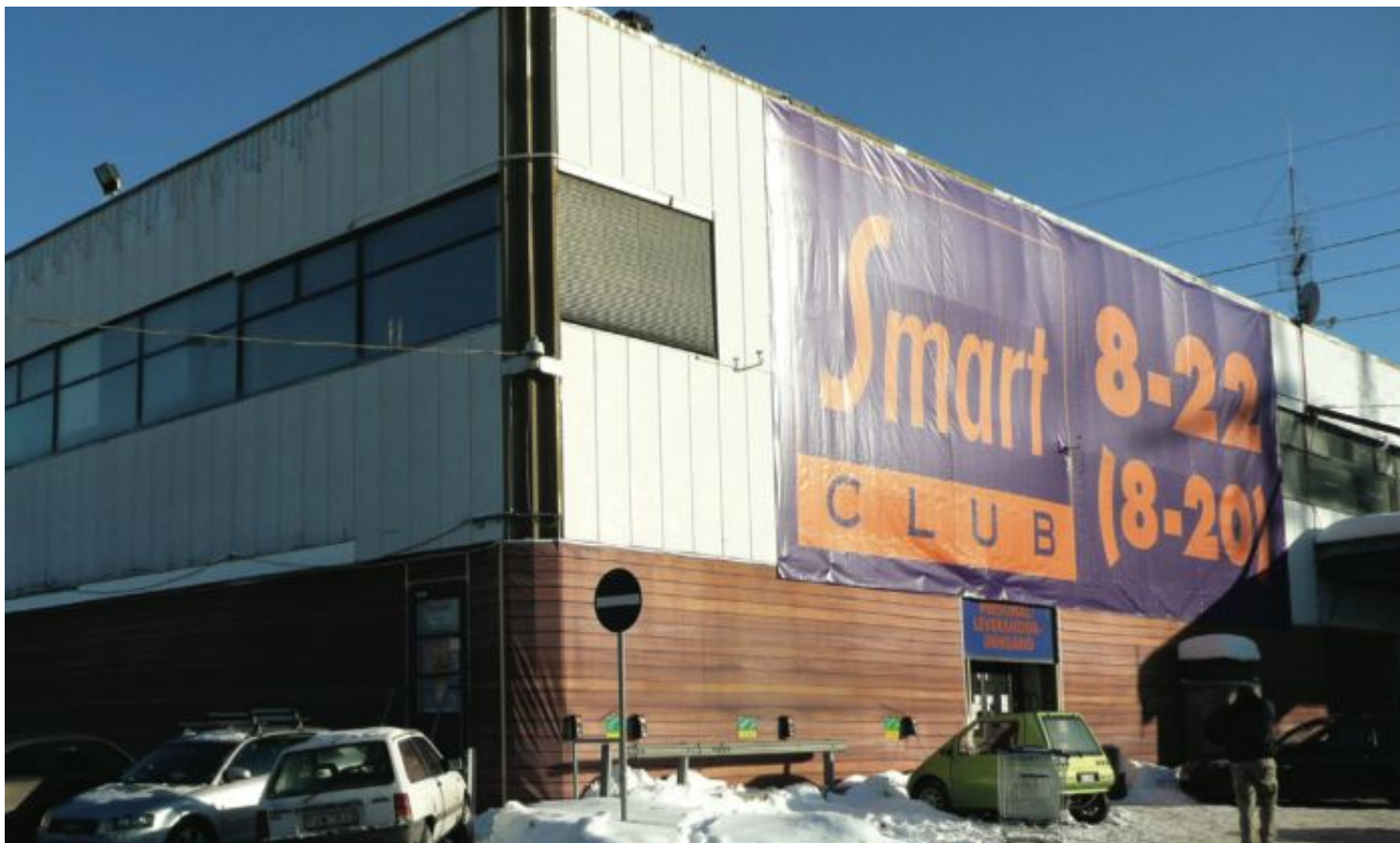
BRYSTPANEL: Du kan lage en stor banner eller dekke hele bygget med tekstil. Legg merke til at også «første etasje» er dekket med stoff, ikke treverk.
